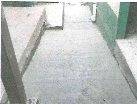
Foto 3: Reparación de Banqueta
