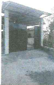
Foto1: Ampliación de portón principal
