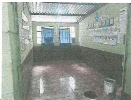
Foto 5: Reparación de Piso
