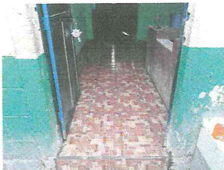
Foto 7: Reparación puertas de metal
