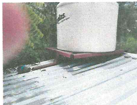
Foto 8: Instalación depósito de agua
