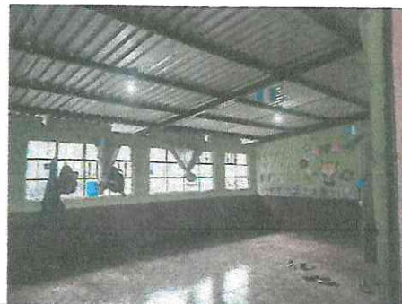
Foto 4: Reparación de Sistema Eléctrico
