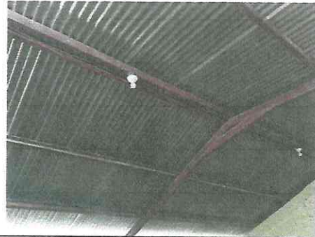
Foto 2: Sustitución de lamina
