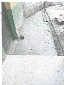
Foto 9: Reparación banqueta de concreto
