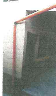
Foto 6: Canales y bajadas de agua pluvial en patio
