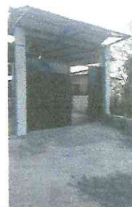
Foto 10: Ampliación rampa de portón
